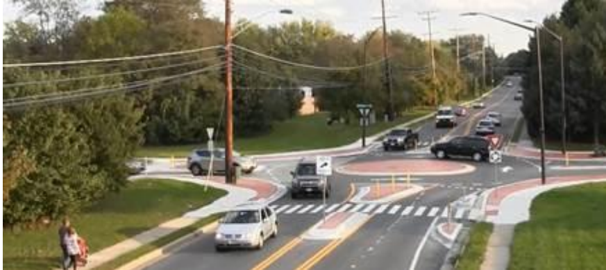
Figure 48. Mini Roundabout/Traffic Circle
